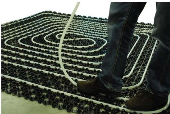
Il passo di posa è legato alla effettiva capacità di riscaldamento/raffrescamento dell'impianto radiante e deve essere deciso dal Professionista incaricato in base alla composizione dei solai, dei sottofondi e del massetto scelto. Normalmente la presenza di solai in legno o di sottofondi in materiale espanso sono già garanzia di possibilità d'installazione.
