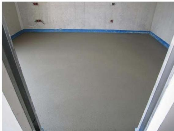
Kloben non è fornitore di questi prodotti che normalmente sono a carico della parte edile nella realizzazione e riqualificazione degli edifici. I vari fornitori permettono la posa di sistemi con almeno 10 mm di spessore di massetto soprattutto e almeno 3 cm totali di spessore di prodotto.
