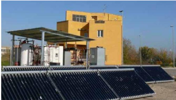
Il solar cooling è una tecnica impiantistica che utilizza l'acqua calda prodotta da collettori solari a tubi sottovuoto per produrre acqua refrigerata o aria condizionata.
